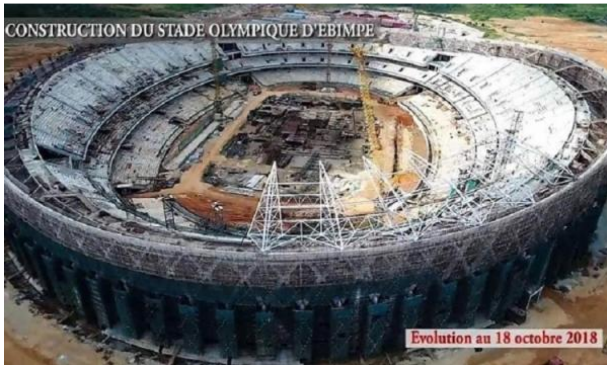
L'évolution de la construction du stade olympique d'Ebimpé, en quelques mois, signe de l'engagement des Ivoiriens à tenir le pari de la Can 2021
